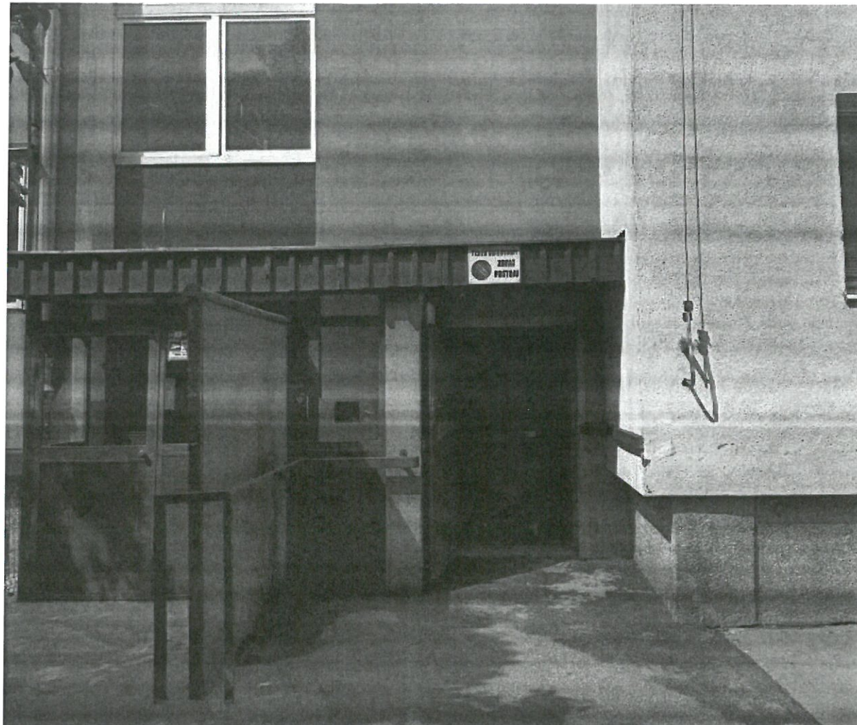
Wejście do budynku przy ul. Dąbrowskiej 3 w Warszawie – Klatka II
